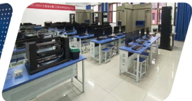
综合布线实训室
